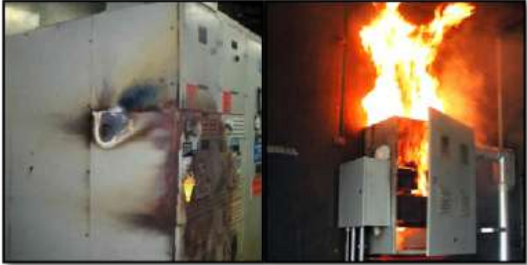
Gambar 2.2. Dampak Arc Flash pada BUS
