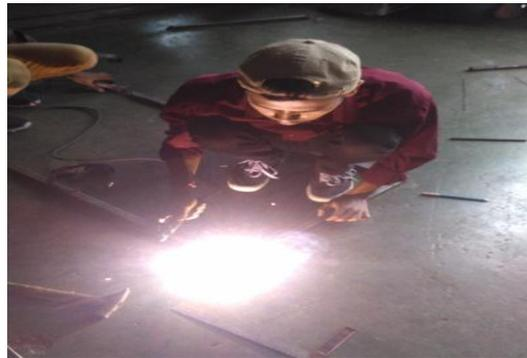
Gambar 3.17 Proses Pengelasan Kerangka Mikrohidro Terapung
