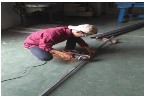
Proses Menggerindra Besi Hollow
