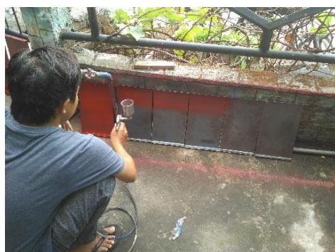
Proses Pengecatan Sudu Turbin
