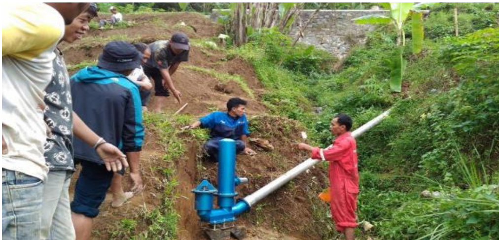
Gambar 4.11 Pemasangan Pompa Hidram Di Hutan
