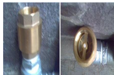
Gambar 10 Kleb Buang, Kleb Tekan Pompa Hidram dan Saringan Air Keluar Pompa Hidram
