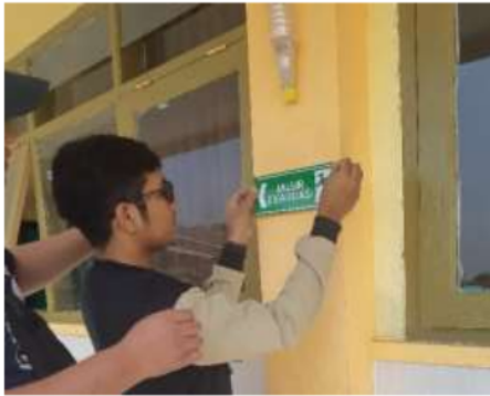
Gambar 2 Peninjauan Lokasi Pelatihan Gambar 3 Pemasangan Jalur Evakuasi
