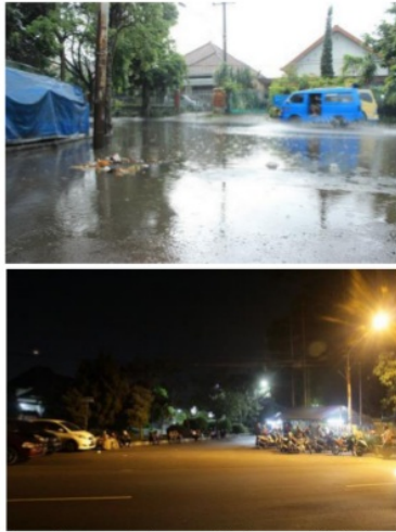
Gambar 4. Sistem jaringan drainase tidak berfungsi optimal saat musim hujan; kondisi penerangan jalan yang redup pada area Jl. Dr. Sutomo (Dokumentasi penulis, 2018)
