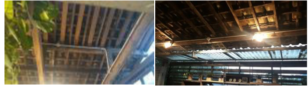
Gambar 18. Atap genteng rangka kayu (Survey Lapangan, 2019)
