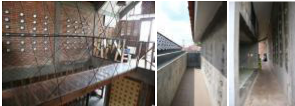
Gambar 5. Penerapan material dinding kombinasi batu bata dengan botol-botol bekas (Survey Lapangan, 2019)
