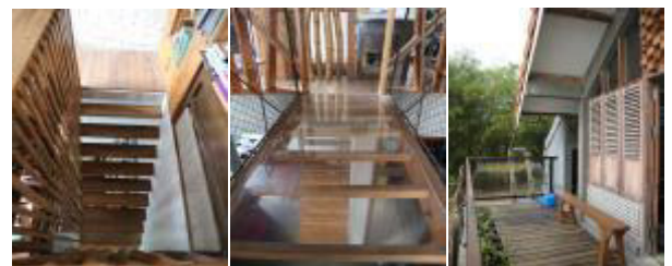
Gambar 3. Penerapan material daur ulang bahan kayu pada lantai 3 (Survey Lapangan, 2019)
