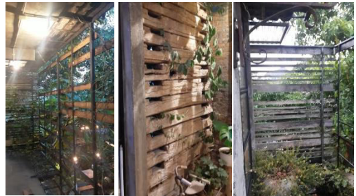
Gambar 20. Elemen partisi kayu dan sunshading (Survey Lapangan, 2019)
