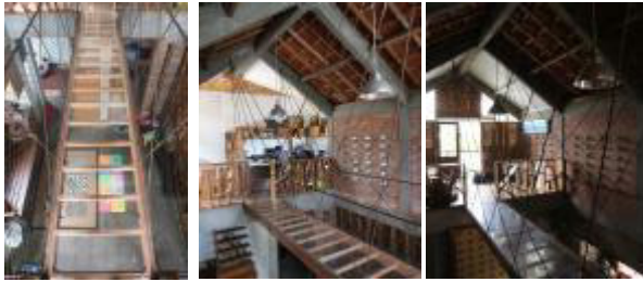
Gambar 4. Penerapan material daur ulang bahan kayu pada jembatan gantung lantai 3 (Survey Lapangan, 2019)
