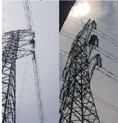
Gambar 1. Persiapan sebelum naik tower listrik
