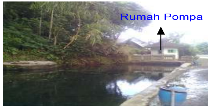
Gambar 2. Sumber Air Umbulan dan Rumah Mesin Pompa Air Desa Ngadireso
