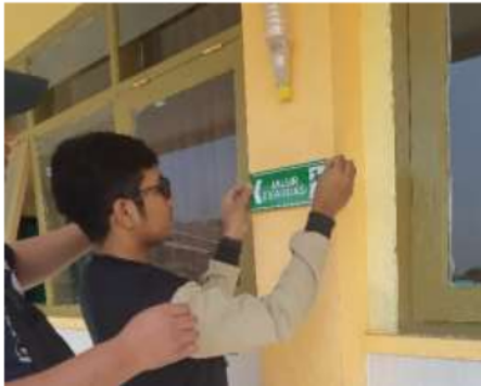
Gambar 2 Peninjauan Lokasi Pelatihan Gambar 3 Pemasangan Jalur Evakuasi
