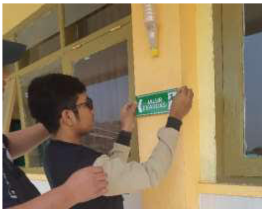
Gambar 2 Peninjauan Lokasi Pelatihan Gambar 3 Pemasangan Jalur Evakuasi
