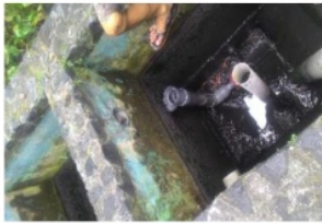
f. Proses pemasangan
