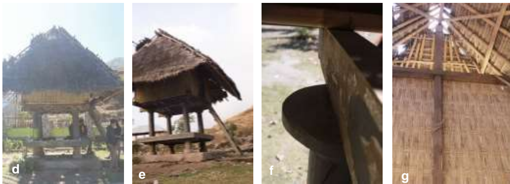
Gambar 2.19. Kode sampel SBL 4 adalah Geleng milik Rumah Adat desa Beleq Sembalun. (a,b, dan c) Olah estetika dan sambungan balok-balok pada Geleng , sama dengan Panteq di Limbangan . (d dan e) Adalah tampak Geleng yang sepintas sama dengan Panteq di Limbangan , perbedaan-nya adalah pada panjang tritisan, kalau Geleng tritisannya lebih pendek. (f) Menunjukkan posisi Jelepeng terhadap balok pendukung tempat padi. (g) Posisi tiang penyangga struktur utama Geleng yang menjadi satu dengan struktur pembatas tempat padi. (photo: Gatot A S)
