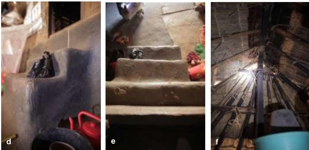
Gambar 2.7. Kode sampel LBT 5 adalah Bale-Tani milik Papuq Raisah di Limbungan Timur, (a dan b) Adalah tampak Bale-Tani , terlihat adanya penaikan muka tanah di ruang dalam. (d dan e) 3 (tiga) anak tangga menghubungkan ruang utama dengan ruang depan, tinggi tiap anak tangga ternyata tidak sama (c) Penyambungan balok dari kayu dan dari bambu dengan cara diikat. (f) Menunjukkan penyelesaian khusus pada bagian atap segitiga. (photo: Gatot A S)
