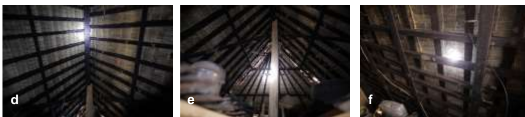
Gambar 2.4. Kode sampel LBB 5 adalah Bale-Tani milik Nur Meneb, (a dan b) Adalah tampak bangunan yang menunjukkan bahwa posisinya di daerah berkontur, sama halnya pada sampel LBB 1 dan LBB 3 bahan utama penutup atap adalah ilalang dan dinding penyekatnya terbuat dari anyaman bambu. (c) Anak tangga yang berjumlah empat dengan ketinggian lebih tinggi dibandingkan dari sampel sebelumnya, ini menunjukkan bahwa leveling di dalam bale lebih tinggi. (d,e, dan f) Struktur penyangga atap menggunakan balok kayu, demikian juga dengan struktur utamanya juga memakai balok kayu. (photo: Gatot A S)
