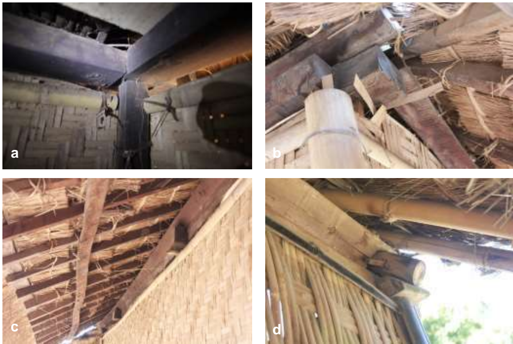
Gambar 4.6. (a) Rangkaian balok lempen dengan teken . (b) Rangkaian pertemuan balok lampen pada bagian sudut dan posisinya terhadap belandar . (c) belandar di atas lampen sebagai penyalur beban. (d) belandar sebagai perangkai kerangka atap. (photo: Gatot AS)
