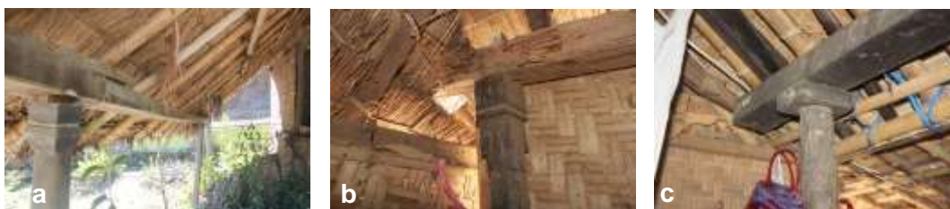
Gambar 5.9. Pengolahan estetikan pada ujung atas tiang penyangga belandar sesangkok di (a) Sembalun, (b) Limbungan, dan (c) Sade. (photo: Gatot AS)
