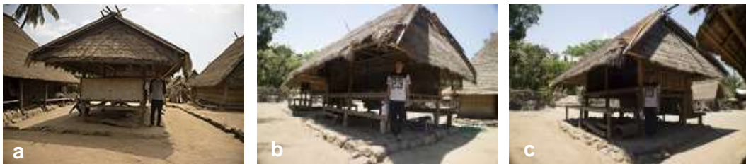
Gambar 5.27. Berugaq sekenem (a) berfungsi untuk duduk-duduk, (b) berfungsi untuk persiapan sesaji, (c) berfungsi sebagai tempat sesaji di Gumantar (photo: Gatot AS)
