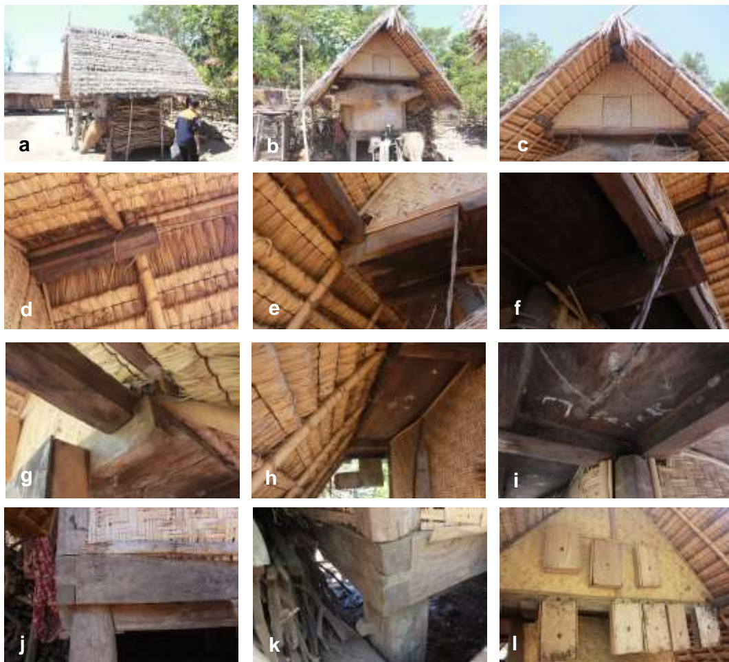
Gambar 2.37. Kode sampel BG 4 adalah Sambi milik Sumajin di desa Beleq Gumantar. (a dan b) Tampak Sambi , disini nampak bahwa bentuk tampaknya berbeda bila dibandingkan dengan bentuk atap Sambi Senaru, atapnya berbentuk perisai. (c) Pintu masuk ke dalam tempat penyimpanan padi posisinya menghadap ke depan, hal ini juga berbeda dengan Sambi Senaru yang pintu masuknya menghadap ke atas. (d) Balok pendukung paling atas/nok. (e, f, dan g) Balok pendukung pada bagian ujung bawah sekaligus sebagai pengunci sistem struktur. (h) Papan penutup samping sekaligus menyatu dengan balok pengunci di samping. (i) Sambungan bagian sudut atas tempat menyimpan padi. (j dan k) Sambungan bagian bawah tempat padi, dengan model ikatan yang khas, serta bagaimana hubungannya dengan kaki yang berbentuk batang bulat. (l) Sisi lain dari Sambi dimanfaatkan untuk tempat ternak tawon. (photo: Gatot A S)
