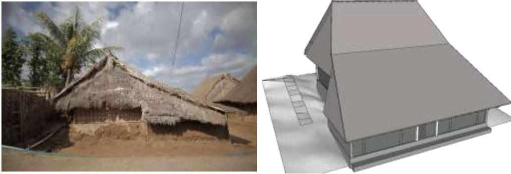
Gambar 4.19. Setelah kerangka atap terpasang dilanjutkan dengan memasang ijuk sebagai bahan atapnya (photo: Gatot AS)
