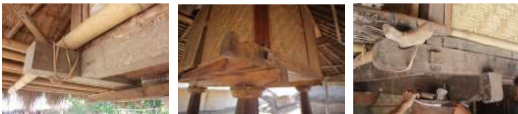
Gambar 5.22. Olahan Estetika pada balok belandar (photo: Gatot AS)
