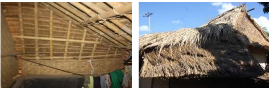
Gambar 4.17. Pemasangan kerangka atap miring sesangkok (photo: Gatot AS)
