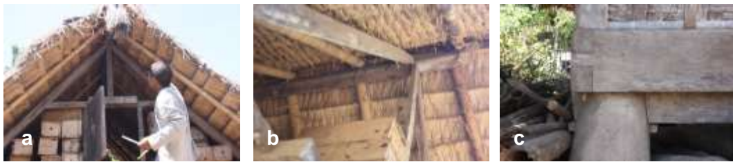
Gambar 2.39. Kode sampel BG 7 adalah Sambi milik Malinom di desa Beleq Gumantar. (a dan b) Dari sini dapat disimpulkan bahwa kerangka bagian luar ini adalah rangka penjaga atap. (c) Untuk sistem struktur pendukung kaki dan bagian bawah tempat padi sama dengan sampel lainnya (photo: Gatot A S)
