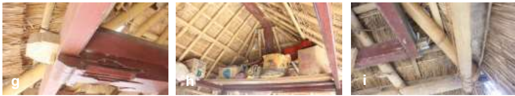
Gambar 2.59. Kode sampel SD 8 adalah Beruqaq milik Bpk Rena di Sade. (a) Tampak Beruqaq yang sedang diambil datanya. (b) Suasana di dalam beruqaq . (c dan d) Penyelesaian rangkaian batang bambu pada ujung nok, seperti sistem yang lainnya. (e) Penyelesaian pada sisi sudut penyangga atap. (f dan g) Macam lain olah estetika pada ujung batang balok. (h) Sisi ujung lain pada beruqaq . (i) Penumpukan batang bambu tidak tepat di ujung struktur utamanya, namun agak menyamping. Posisi lembar atap yang panjang di atas yang pendek. (photo: Gatot A S)
