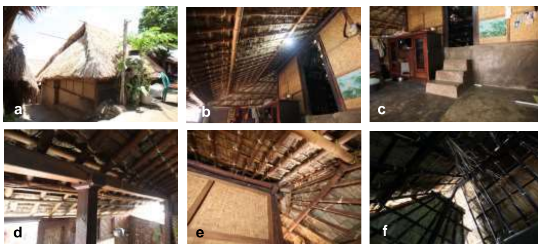
Gambar 2.52. Kode sampel SD 3 adalah Bale Tani milik Amaq Juna di Sade. (a ) Tampak belakang Bale Tani Sade. (b). Nampak ruang depan yang tanpa dinding depan, difungsikan untuk menjajakan barang sunenier kepada wisatawan. (c) Penyelesaian tangga dan lantai yang sedang menggunakan PC, sehingga nampak lebih mengkilap. Biasanya menggunakan campuran tanah liat dengan korotan sapi. (d) Tiang penyangga balok depan bentuknya dibuat berestetik. (e dan f) Penyelesaian penggabungan batang bambu mengerucut pada bagian atasnya. (photo: Gatot A S)
