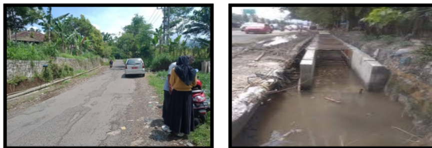
Gambar2. Kondisi eksisting Ruas Jalan Krucil- Tambelang (R.53)
