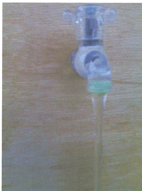
Gambar 4.6 Deras Air Wudhu Kran Manual Terbuka Besar
