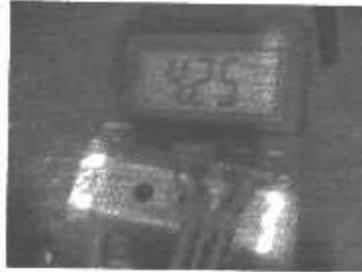
Gambar 4.4 Pengukuran Tegangan Setelah Melewati Dioda
