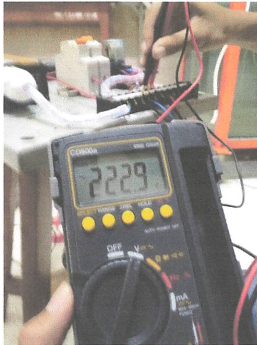
Gambar 4.4 Tegangan PLN Setelah dibebani
