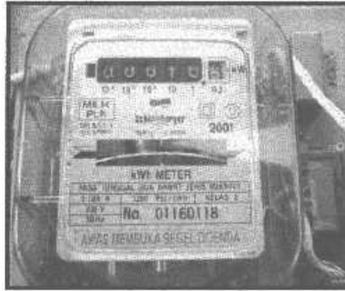
Gambar 2.1 kWh Meter Analog
