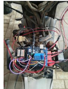
Gambar 12 Tampilan proses pemasangan alat
