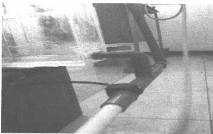
Pemasangan Sensor pada Pipa Irigasi
