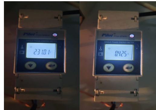
Gambar 4.7 Tampilan Indikator GTI yang terhubung dengan Power meter
