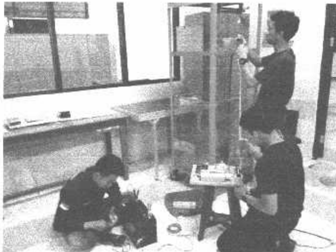
Gambar 4.6 Pemasangan Sumber Tegangan Ke Beban
