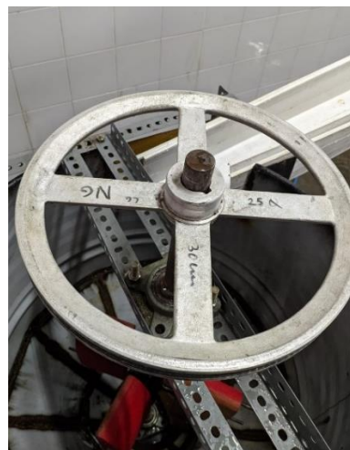
Pemasangan poros turbin ke rumah turbin
