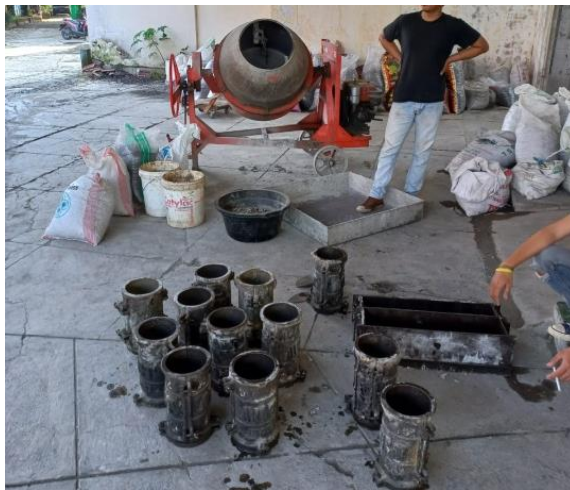
Pembersihan dan Pelumasan Cetakan Sebelum Pengecoran
