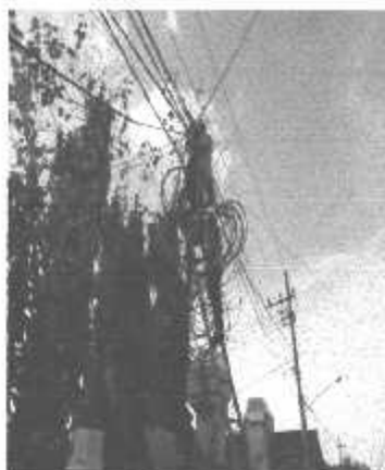
Gambar 3.18 Pemasangan Kabel FO pada ODP
