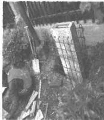
Gambar 3.17 Pembuatan Pondasi ODC
