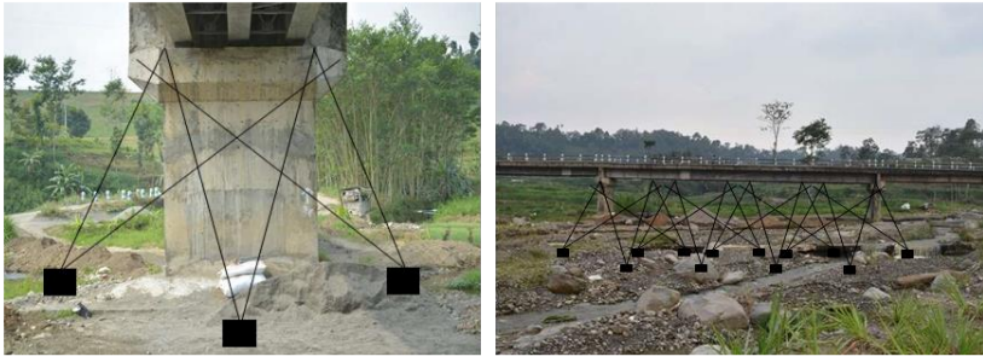
Gambar 2. Pola pemotretan konvergen pada objek jembatan
