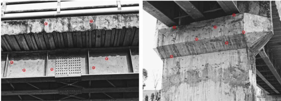
Gambar 3. Titik-titik pantau deformasi pada objek jembatan
