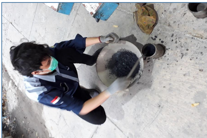
Proses Memasukan Campuran Ke Dalam Cetakan
