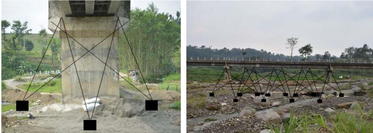
Gambar 2. Pola pemotretan konvergen pada objek jembatan
