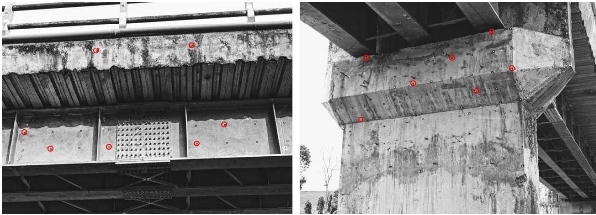
Gambar 3. Titik-titik pantau deformasi pada objek jembatan
