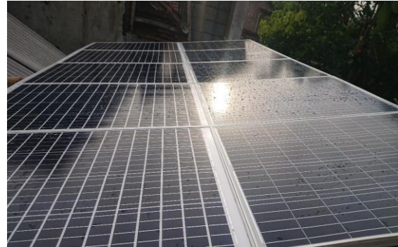
Gambar 4.3 Pemasangan panel surya.
