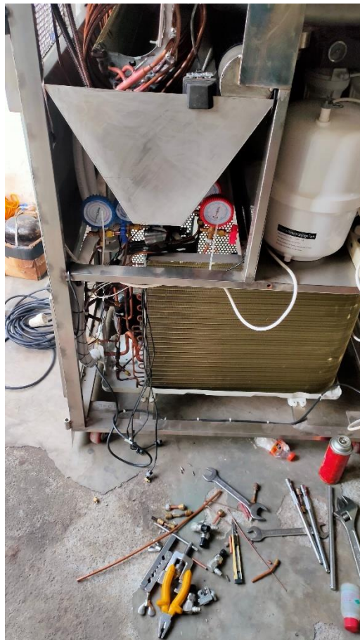
Lampiran proses pemasangan pipa tembaga dan pengisian refrigerant
