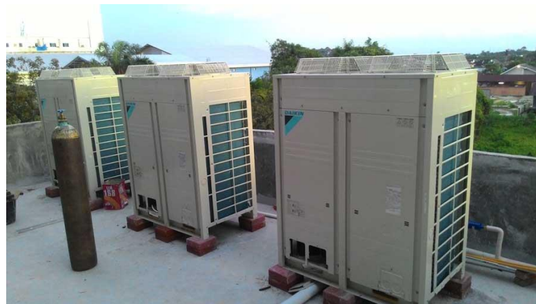
Gambar 4.25 Condenser untuk AC model central
