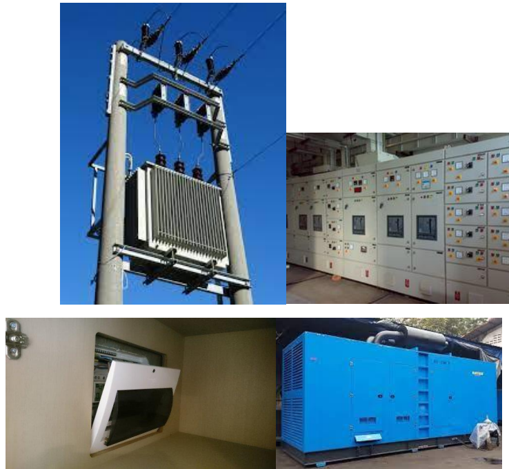
Gambar 4.26-29 Searah jarum jam: Trafo listrik 20.000 Volt, Electrical Control Panel, Generator Listrik alternatif output listrik selain dari PLN MCB yang biasa ditemui di sebuah kamar hotel
