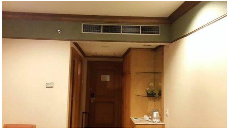
Gambar 4.24 AC model split yang diletakkan secara tertutup/tersembunyi
