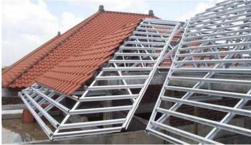
Gambar5.11 Struktur rangka atap dan penutup atap pada bangunan
