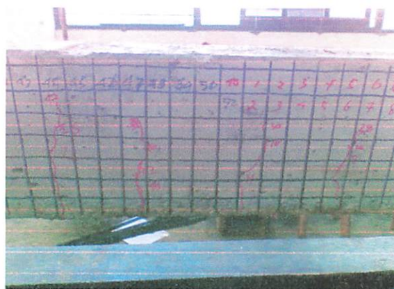
Gambar 4.15 Rekam retak yang terjadi pada balok variasi 2 B
