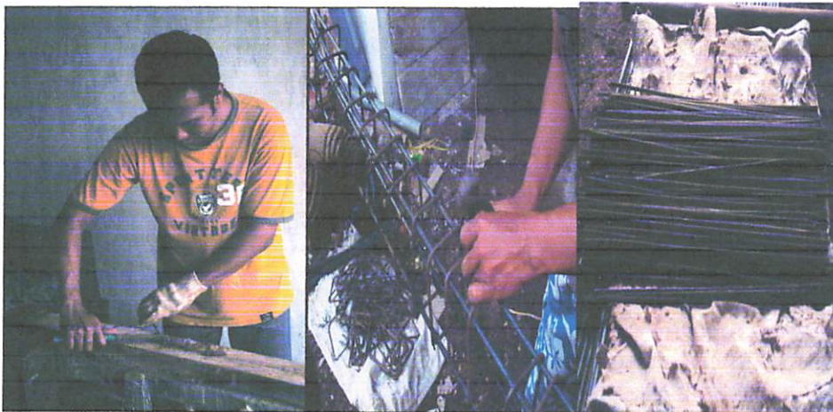
Pembuatan sengkang, Perakitan, Uji slump
