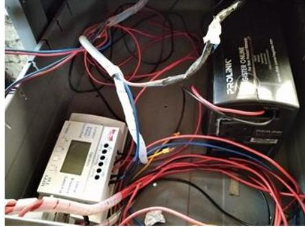
Gambar 4. Pengecekan *inverter* yang telah terpasang sebelumnya
