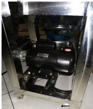
Pemasangan Motor Listrik
