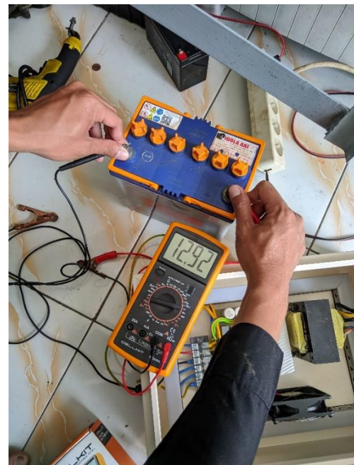
Gambar 1. 3 Pengukuran Tegangan Baterai
