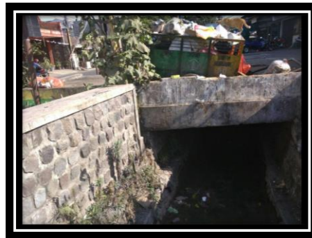
Gambar 4.13 Hasil survey sampah dan bangunan
