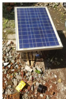
Gambar 4.3 PV tanpa penutup
