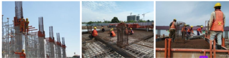
Gambar 1.1 Pekerjaan bekisting, pembesian dan pengecoran beton pada proyek pembangunan gedung kampus II UINSA Surabaya
