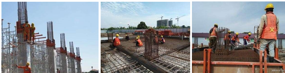
Gambar 1.1 Pekerjaan bekisting, pembesian dan pengecoran beton pada proyek pembangunan gedung kampus II UINSA Surabaya Sumber: Dokumentasi penelitian (2021)
