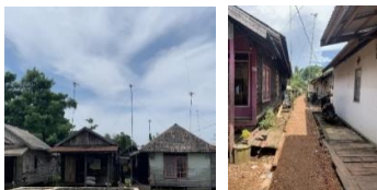
Gambar 4. 5 Kondisi Fisik Bangunan berdasarkan jarak antar bangunan
