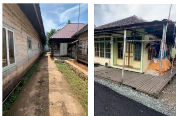
Gambar 4. 3 Kondisi Fisik Material Dinding Bangunan
