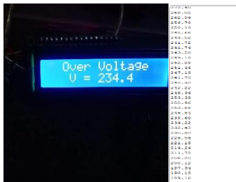
Gambar 8. Kondisi Over Voltage
