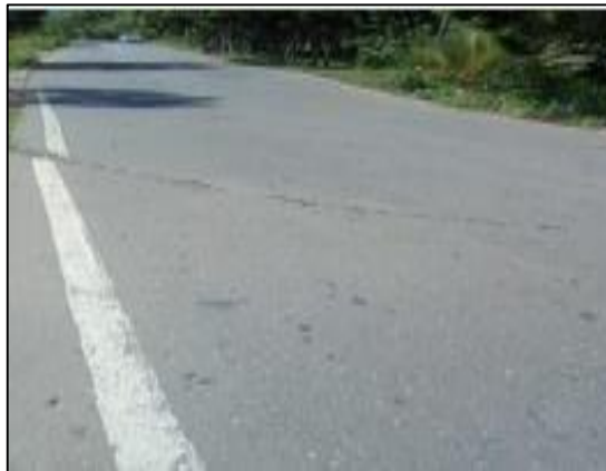
Gambar 2. 2 Retak Melintang (Bina Marga, 2011)
