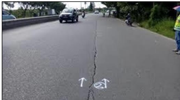
Gambar 2. 1 Retak Memanjang (Bina Marga, 2011)
