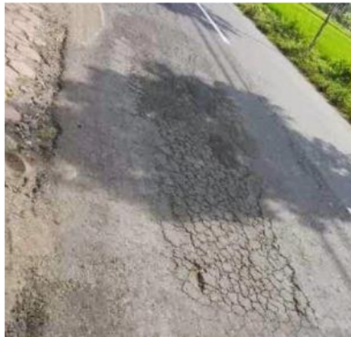
Gambar 2.2 Kerusakan retak kulit buaya Sumber : www.google.com
