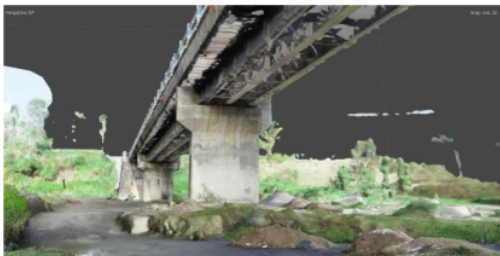
Gambar 7. Struktur Bawah Jembatan
