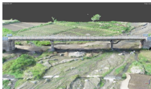
Gambar 5. Struktur Samping Kanan Jembatan
