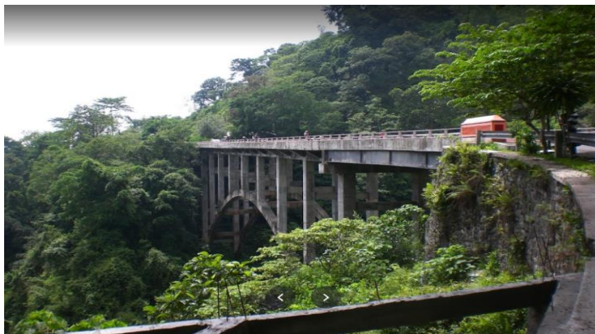
Gambar 1. 1 Kondisi Eksisting Jembatan Sungai Besuk Kobok'an
