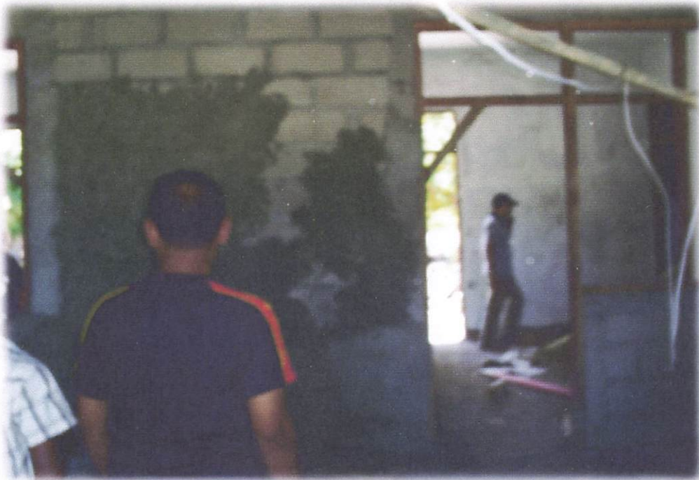
PEKERJAAN PLESTERAN DINDING ( 1 )
