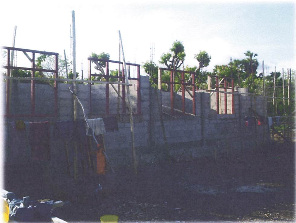
PEKERJAAN PASANGAN DINDING ( 2 )
