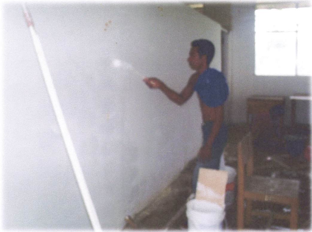
PEKERJAAN PENGECATAN DINDING.
