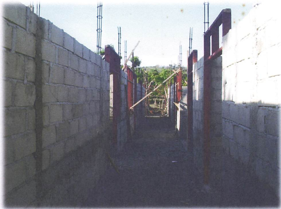
PEKERJAAN PASANGAN DINDING ( 1 )
