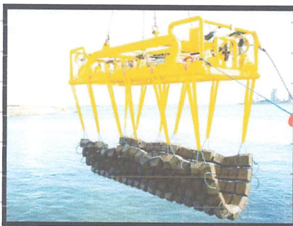
Gambar 2.11. Konstruksi concrete matrass (Lubis, 2014)
